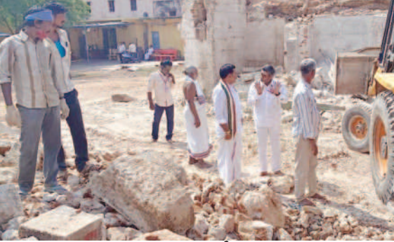
వరదరాజస్వామి లలయం పనులను పరిశీలించిన లధికారులు, ఇంజనీర్లు
